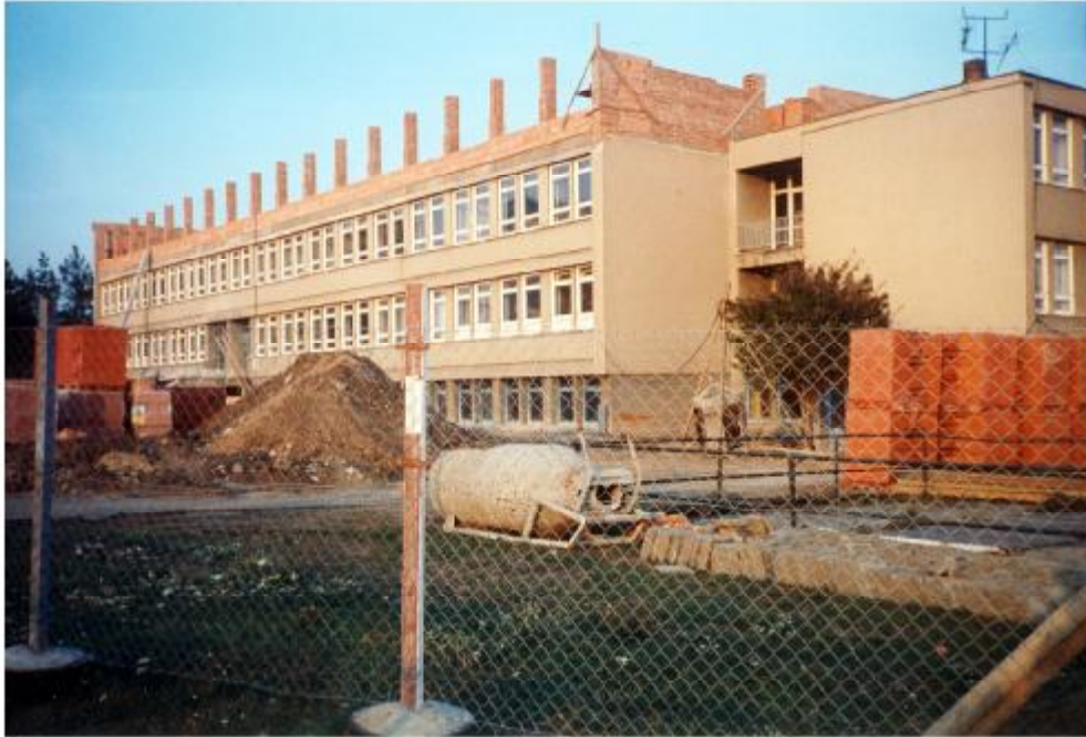
Průběh rekonstrukce ve školním roce 1994-95
