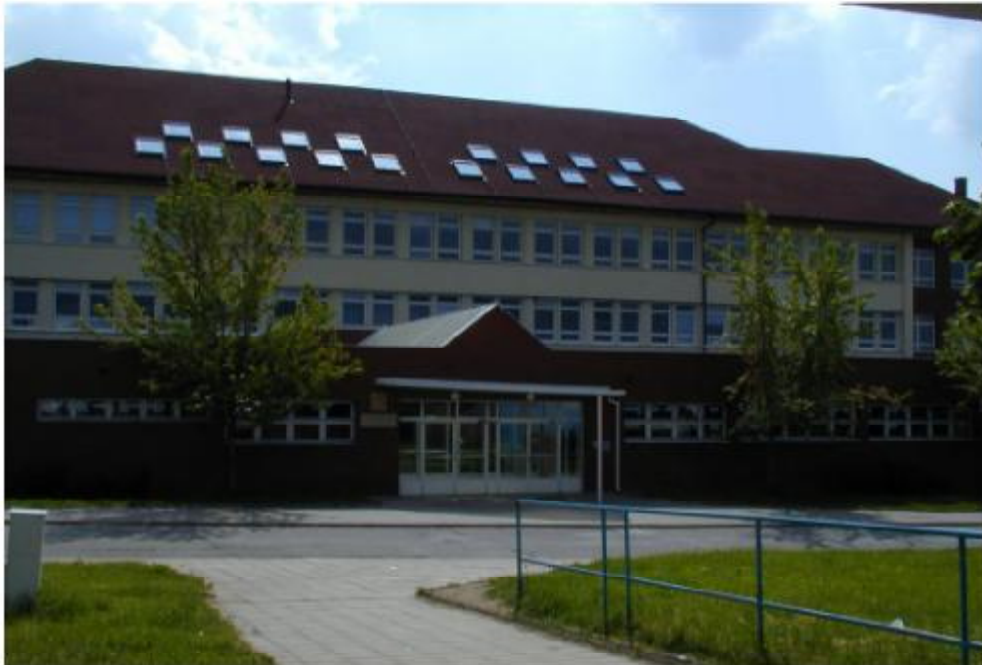
Budova gymnázia po rekonstrukci – hlavný vchod
